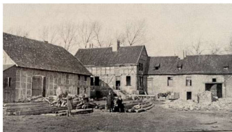
Marode und baufällig: Das Anwesen Haus Wittringen war in einem erbärmlichen Zustand, als die Stadt es 1922 übernahm.
